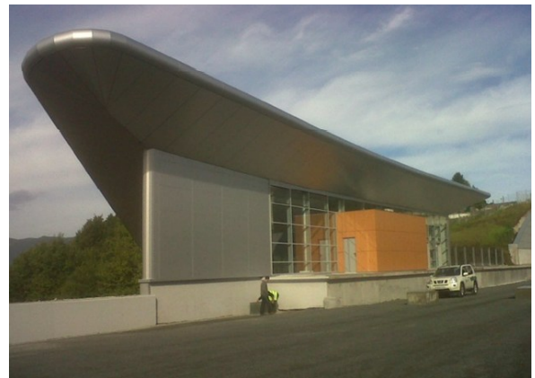
Nueva estación de alta velocidad de Redondela
