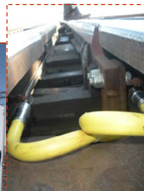
AGUTERM Plus: Detalle de instalación de las resistencias, armario equipamiento y caja distribución.
