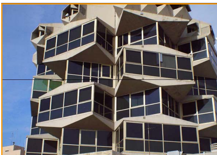
Edificio del centro de telecomunicaciones del Port de Tarragona
