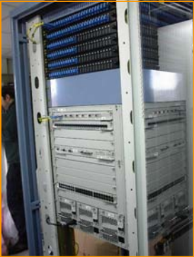
Aspecto de uno de los armarios rack con accesorios 3DNET de fibra óptica y equipamiento activo de datos.
