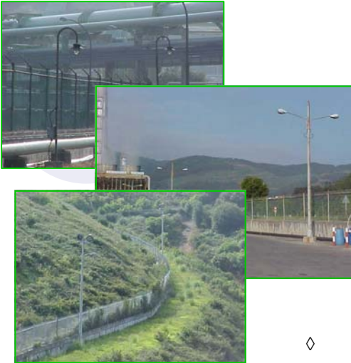
Fotos del perímetro con diferentes tipos de elementos de iluminación, algunos poco eficientes para tareas de video-vigilancia y otros con un consumo energético elevado.
